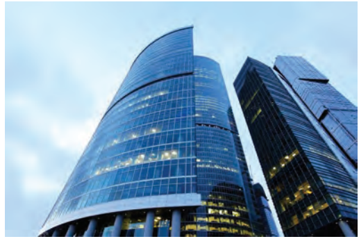
Рис. 149. Современное офисное здание
