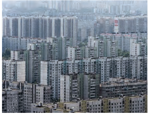
Рис. 109. Ужас архитектуры спальных районов, в которых доминируют регулярные высотки
