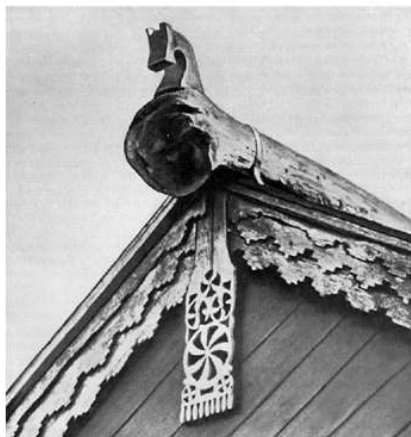
«ГРОМОВЫЙ ЗНАК» ПОД КОНЬКОМ КРЫШИ. Север
